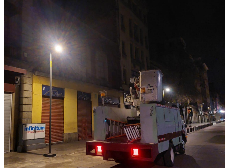
CAMBIO DE BALASTRO Y LÁMPARA
