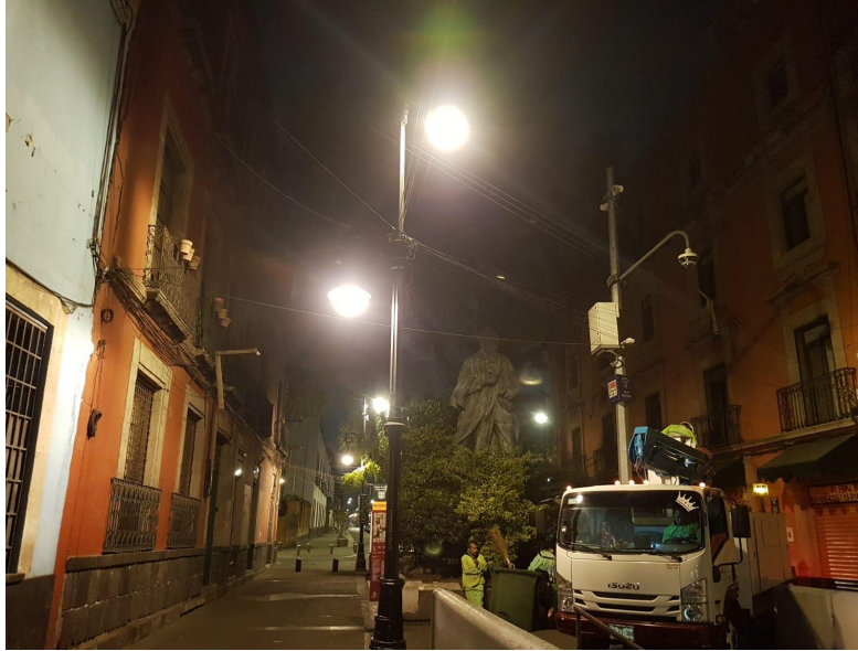
CABLEADO DE LÍNEAS Y CAMBIO DE BALASTRO
