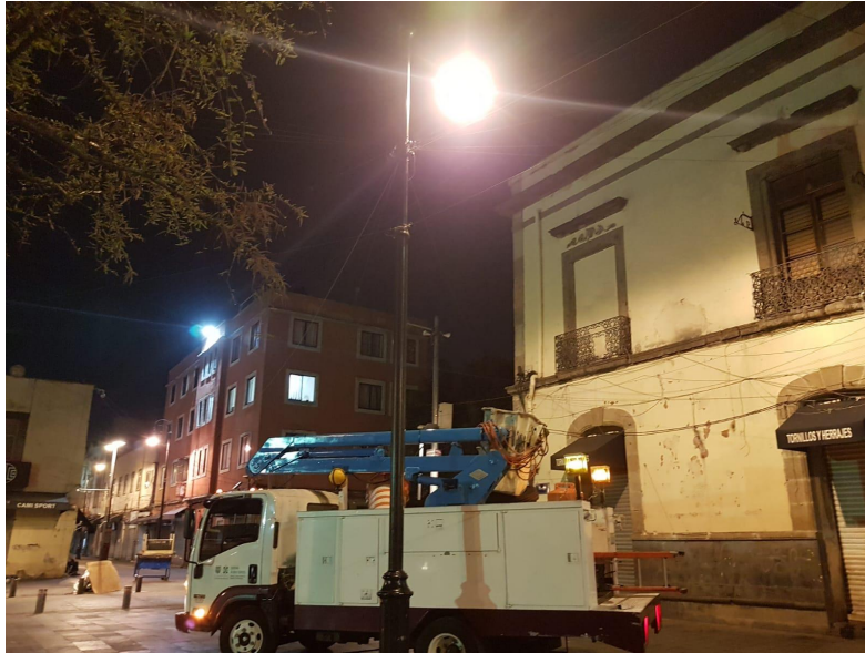
CAMBIO DE LÁMPARA Y BALASTRO
