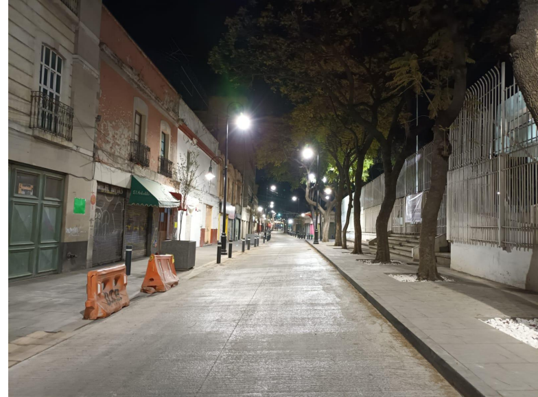
RECONEXIÓN DE LÍNEAS
