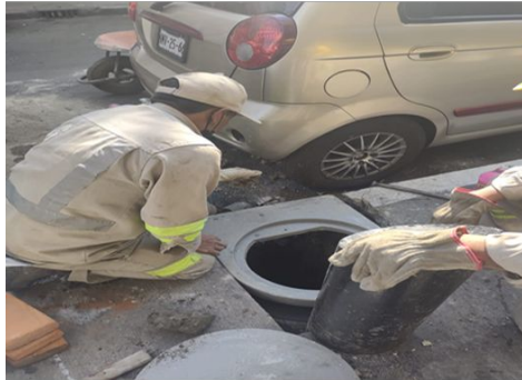
Cambio de brocal en calle Buen Tono 85
