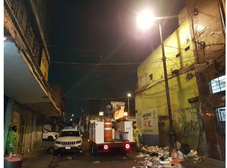
CAMBIO DE BALASTRO
