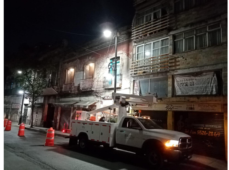
RESTABLECIMIENTO DE INTERRUPTOR TERMOMAGNÉTICO
