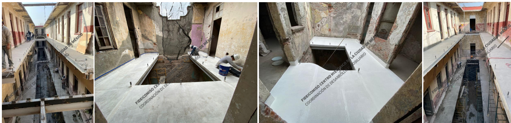
Reintegración de pasillos de patio central y patios interiores.
