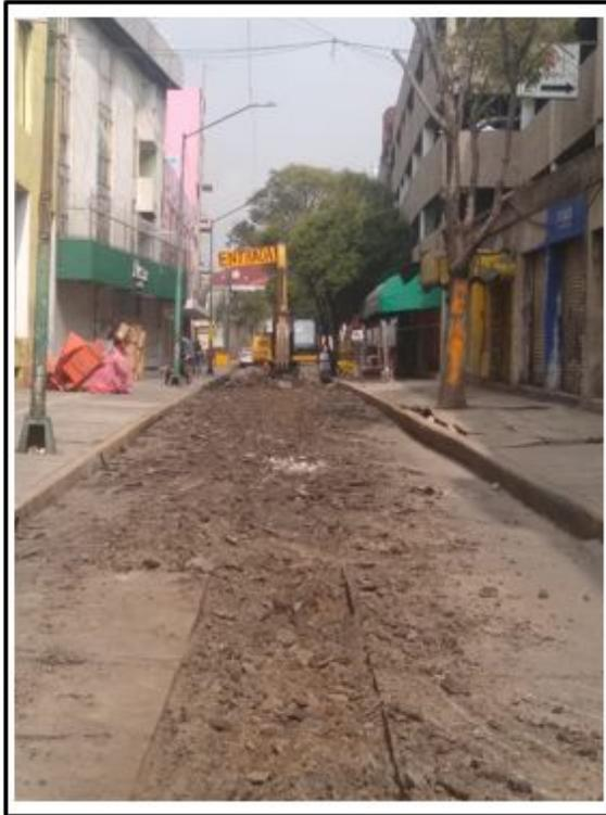
Trabajos de demolición de asfalto sobre calle Órgano entre calle República de Ecuador y ceje 1 norte.
