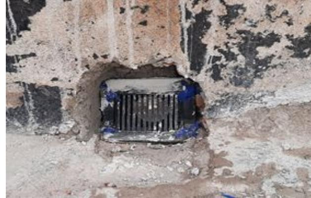
Colocación de coladeras de pretil para bajadas pluviales ubicadas en azotea.
