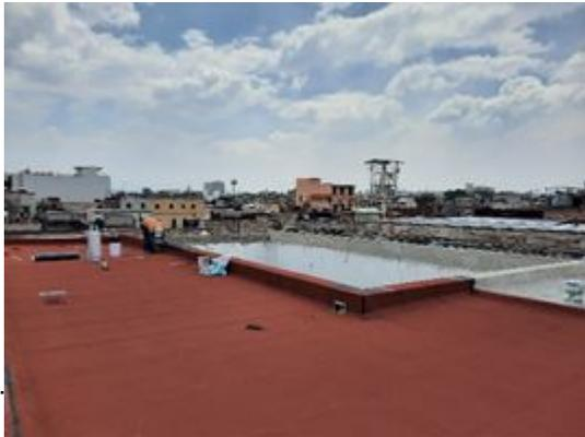
**Colocación de impermeabilizante en pretiles de azotea del patio principal.**
