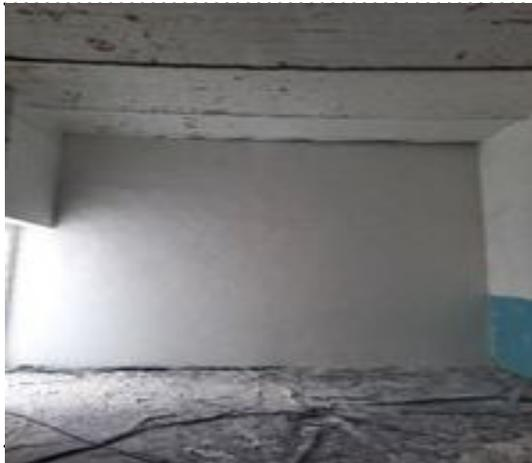
**Preparación de superficie de muros y plafones en aulas de planta alta, para recibir acabado final de pintura.**
