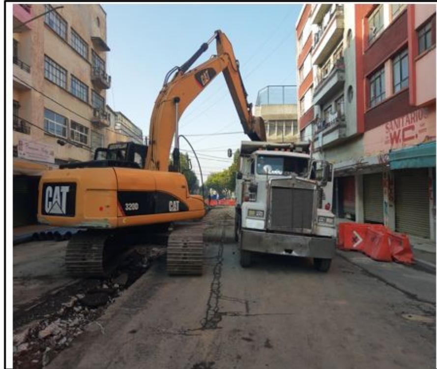
Acarreo producto de excavación de drenaje sobre calle Órgano entre República de Ecuador y Eje 1 norte.
