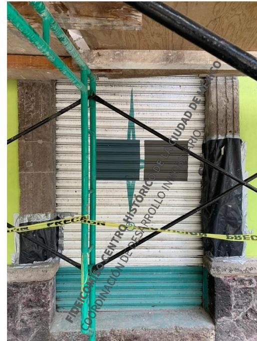
**Bucareli No. 154:** Consolidación de sillares de cantera, muestras de pintura en cortinas para autorización por parte de INAH.
