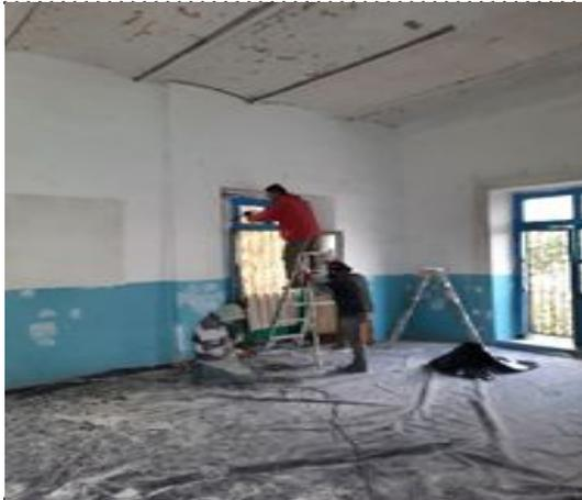
Trabajos de desmontaje de cancelería de madera en aulas planta alta.
