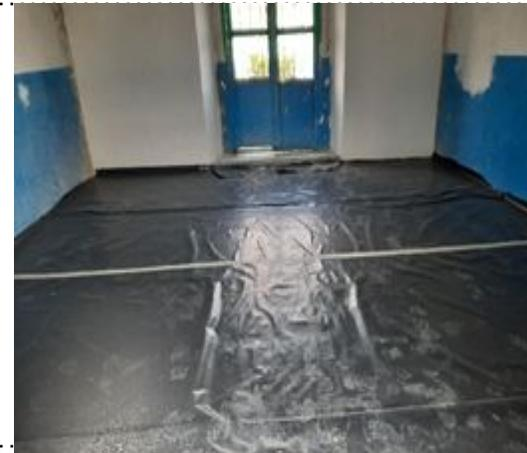
**Protección de pisos de las aulas de planta alta para realizar trabajos de pintura en muros y plafones.**
