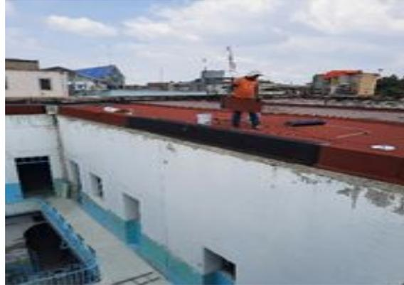
Rehabilitación de bajadas pluviales e impermeabilización de pretilos.
