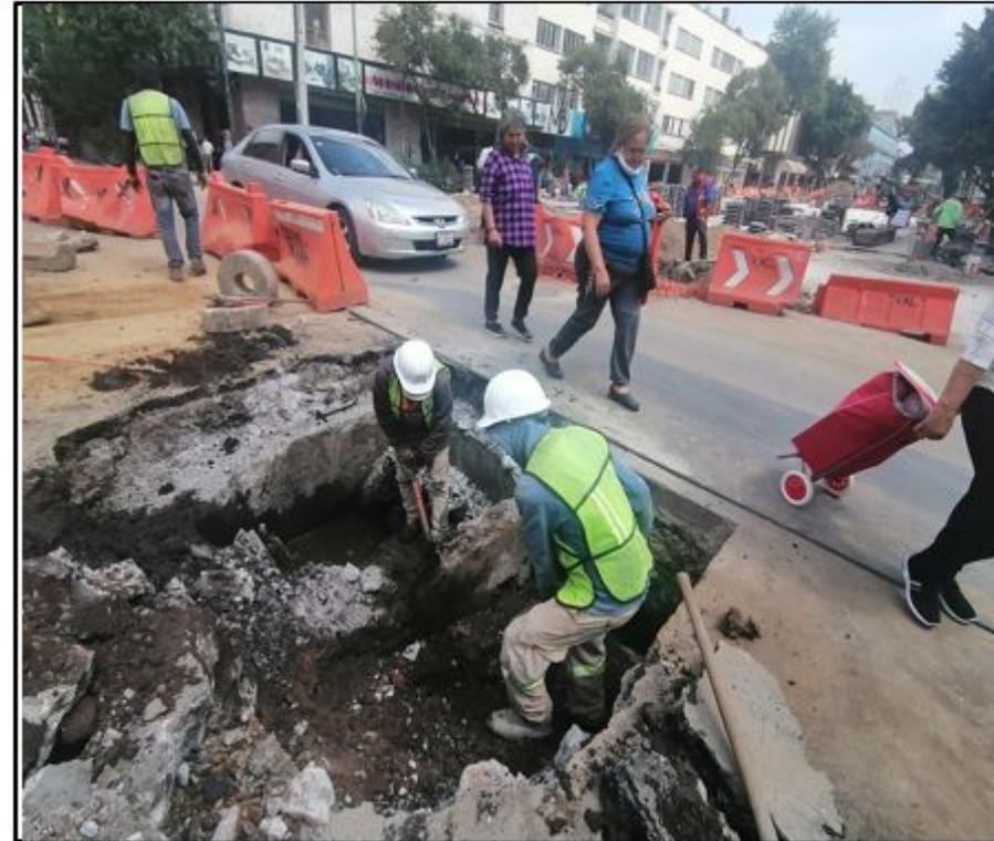
Trabajos de demolición en caja válvulas sobre calle Comonfort esquina con calle república de Ecuador.
