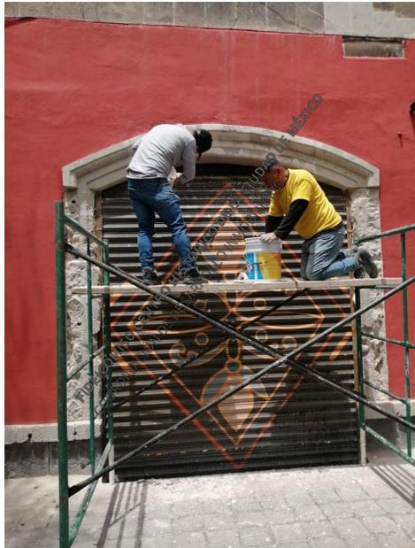
**Bucareli No. 53:** Aplicación de pátina como parte del proceso de remoldeo de sillares de cantera.
