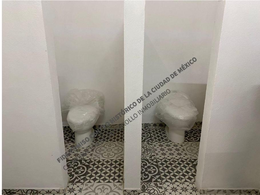
Colocación de acabado en pisos, muebles y aplicación de pintura en muros del núcleo de sanitarios.
