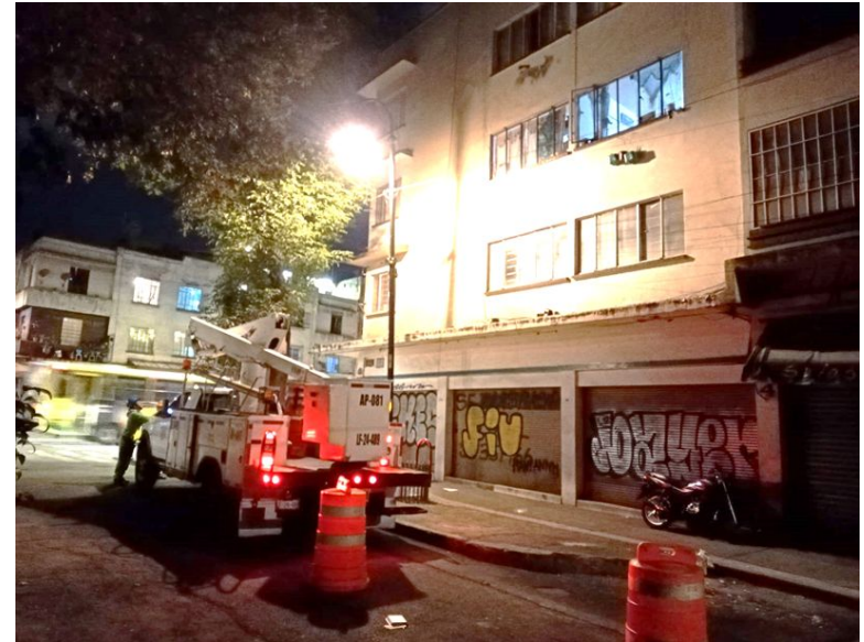
CAMBIO DE BALASTRO
