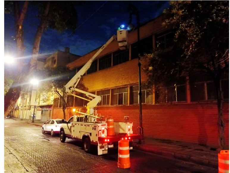
RECONEXIÓN DE LÍNEAS DE ALIMENTACIÓN
