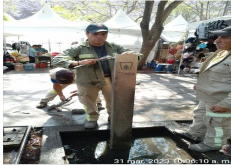
Reparación de fuga de agua en Hidalgo y Angela Peralta
