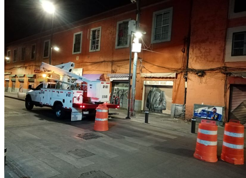
RECONEXIÓN DE LÍNEAS DE ALIMENTACIÓN
