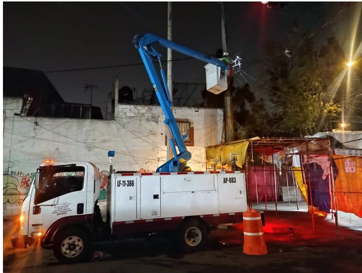
ELIMINACIÓN DE EMPALMES SULFATADOS
