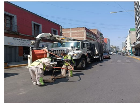
Desazolve en calle Dolores
