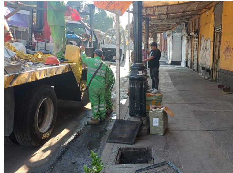
RECONEXIÓN DE LÍNEAS DE ALIMENTACIÓN
