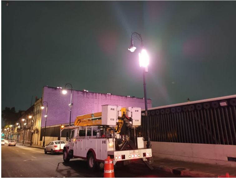
RECONEXIÓN DE LÍNEAS DE ALIMENTACIÓN
