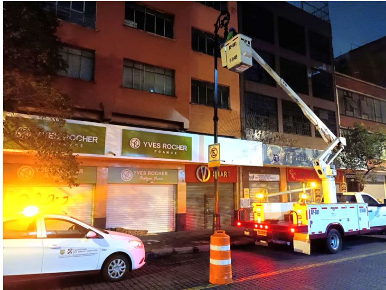
CAMBIO DE BALASTRO
