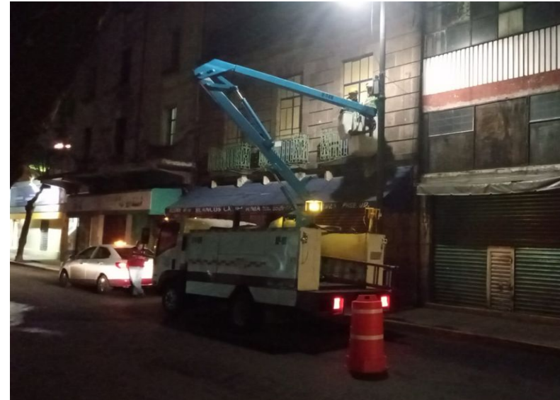
RECONEXIÓN DE LÍNEAS DE ALIMENTACIÓN
