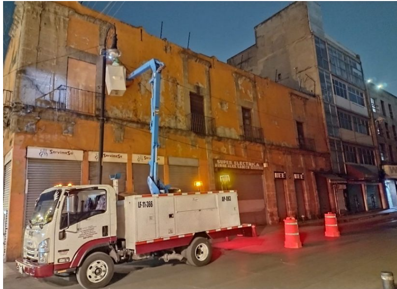
CAMBIO DE FOTOCELDA DAÑADA
