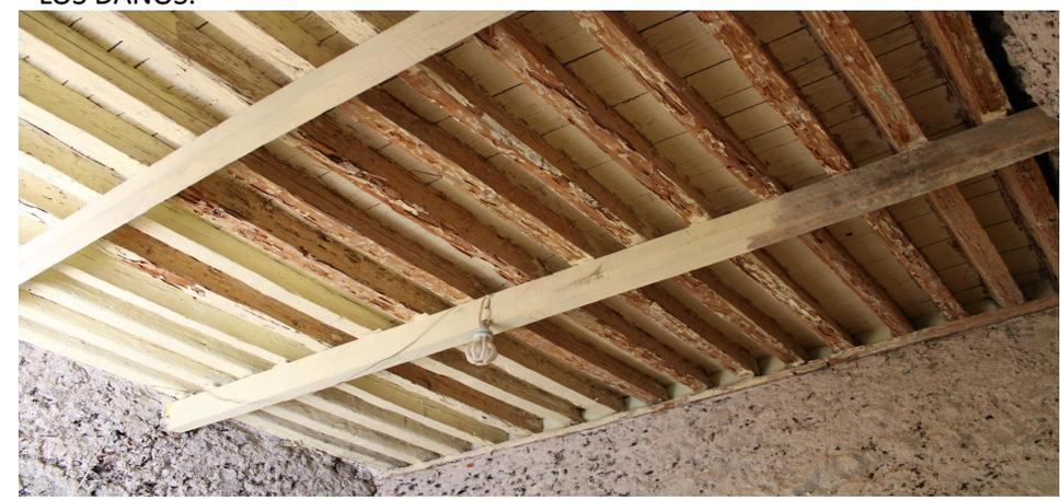
LIMPIEZA DE MURO Y VIGAS PARA DETERMINAR EL TRATAMIENTO DE LA MADERA Y TRABAJOS A SEGUIR.
