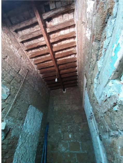
RETIRO DE APLANADOS EN MUROS EN MAL ESTADO DERIVADO DEL EXCESO DE HUMEDAD, SE INICIA LA LIMPIEZA DE VIGAS IDENTIFICANDO EL GRADO DE DETERIORO PRODUCIDO POR LOS INSECTOS XILOFAGOS
