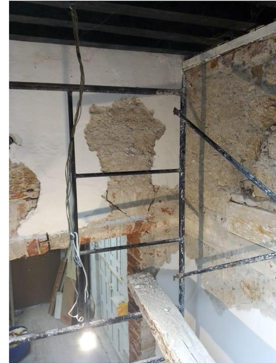
SE INICIA CON EL RETIRO LOS APLANADOS EN MUROS DE LA VIVIENDA 4, IDENTIFICANDO EL GRADO DE DAÑO (A SIMPLE VISTA NO SE APRECIABAN LAS GRITAS Y FISURAS LOCALIZADAS).
